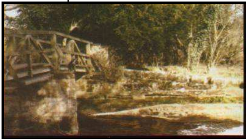
Figura 15: A ponte sobre a barragem no Moinho Saxon. O muro do outro lado do rio é onde a pedra de berilo foi encontrada
